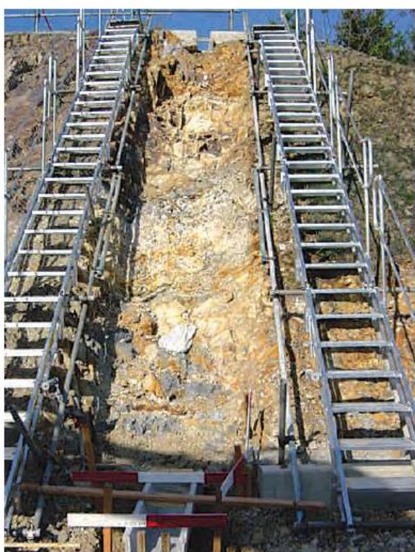
砂防流路工事(昇降及び作業足場)
