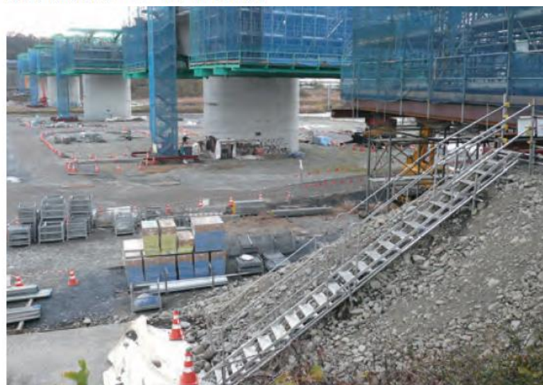
上部工工事の昇降用通路
